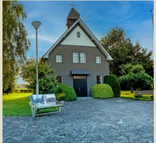
St. Helena Kapelle vor der Renovierung der Außenanlagen
